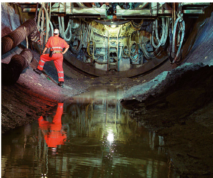
Das Jahrhundertbauwerk des Gotthard-Basistunnels war spektakulär, die Schlichtungen und Vereinbarungen der Baumediation verlaufen eher ruhiger.
